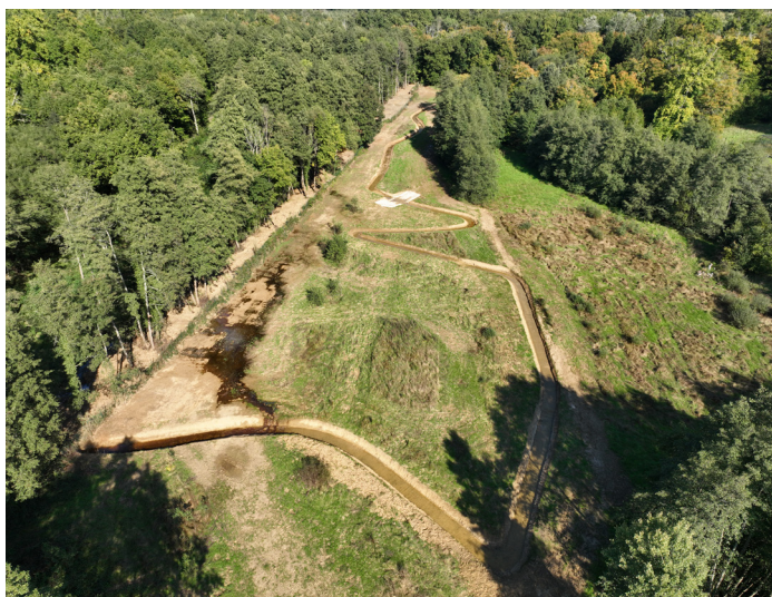
Ru de Saint-Victor après travaux
