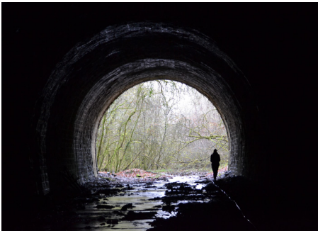
Entrée du tunnel
